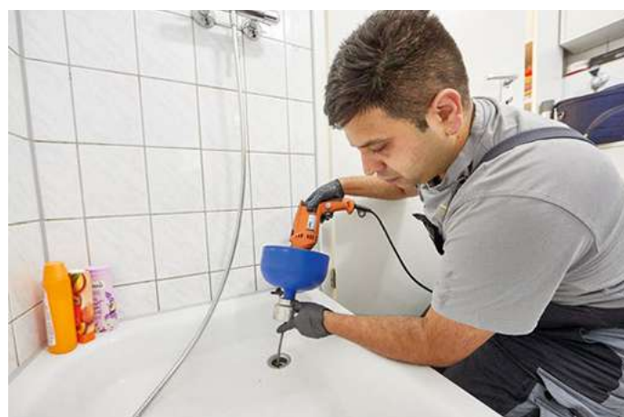
Ausgerüstet mit seiner Handmatic rückt Nihat Kilin Verstopfungen im Abflussrohr einer Dusche zu Leibe
