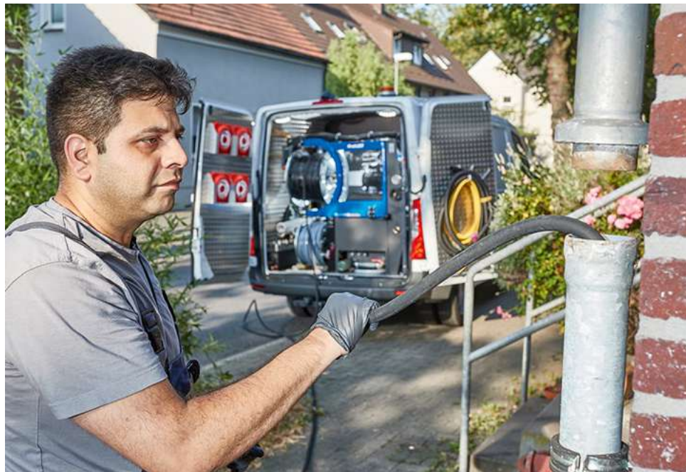
Auch im Hauptrohr kann sich etwas festgesetzt haben. Dann kommt der Hochdruckspüler zum Einsatz
